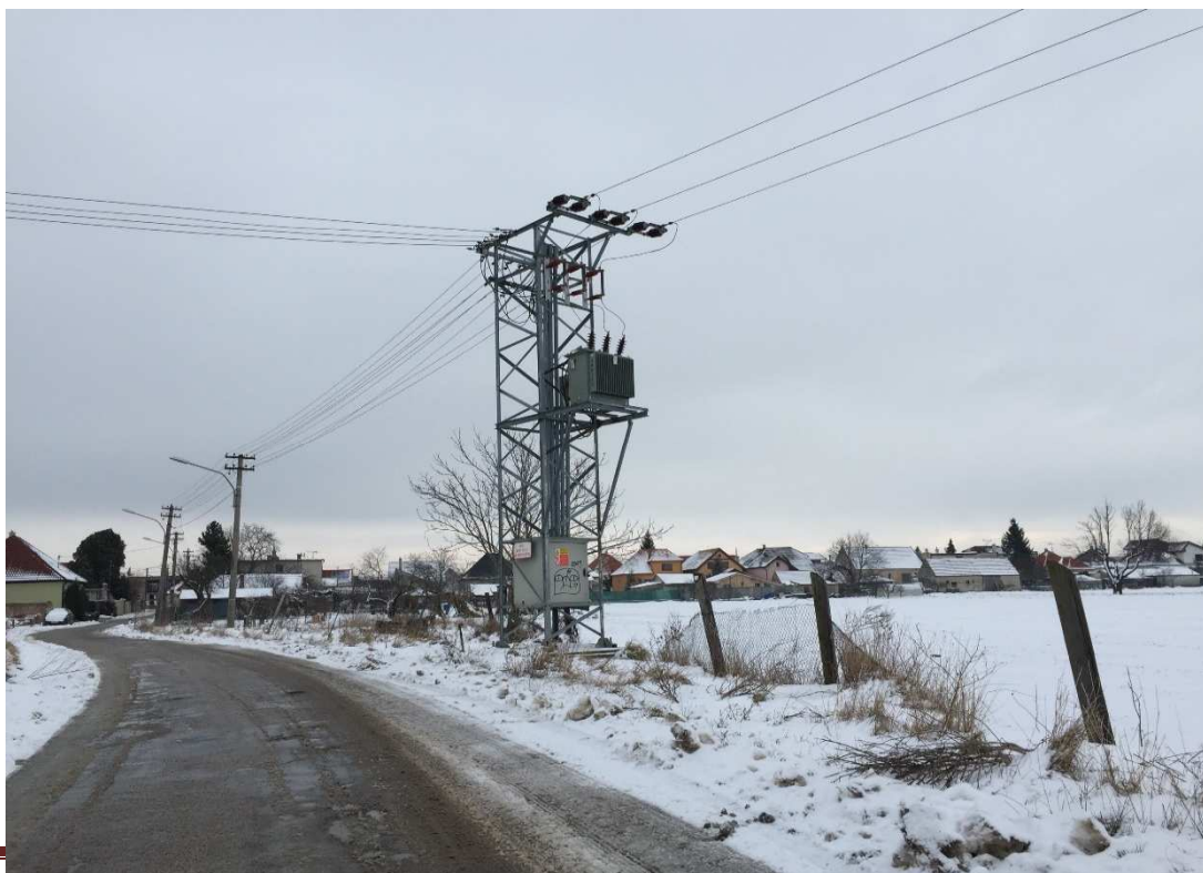
Obr. č. 10: Existujúca trafostanica
