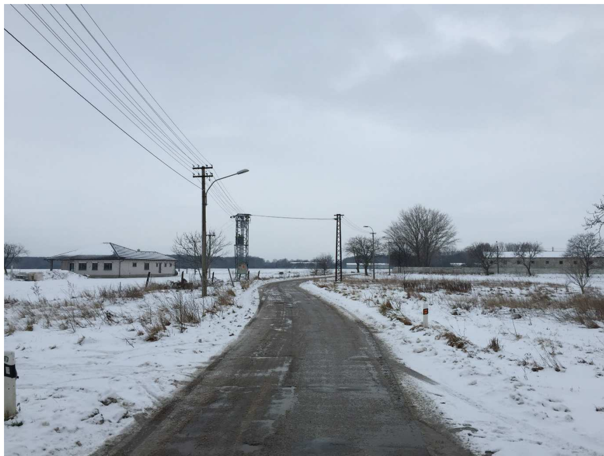
Obr. č. 8: Elektrické vedenie VN a NN a verejné osvetlenie
