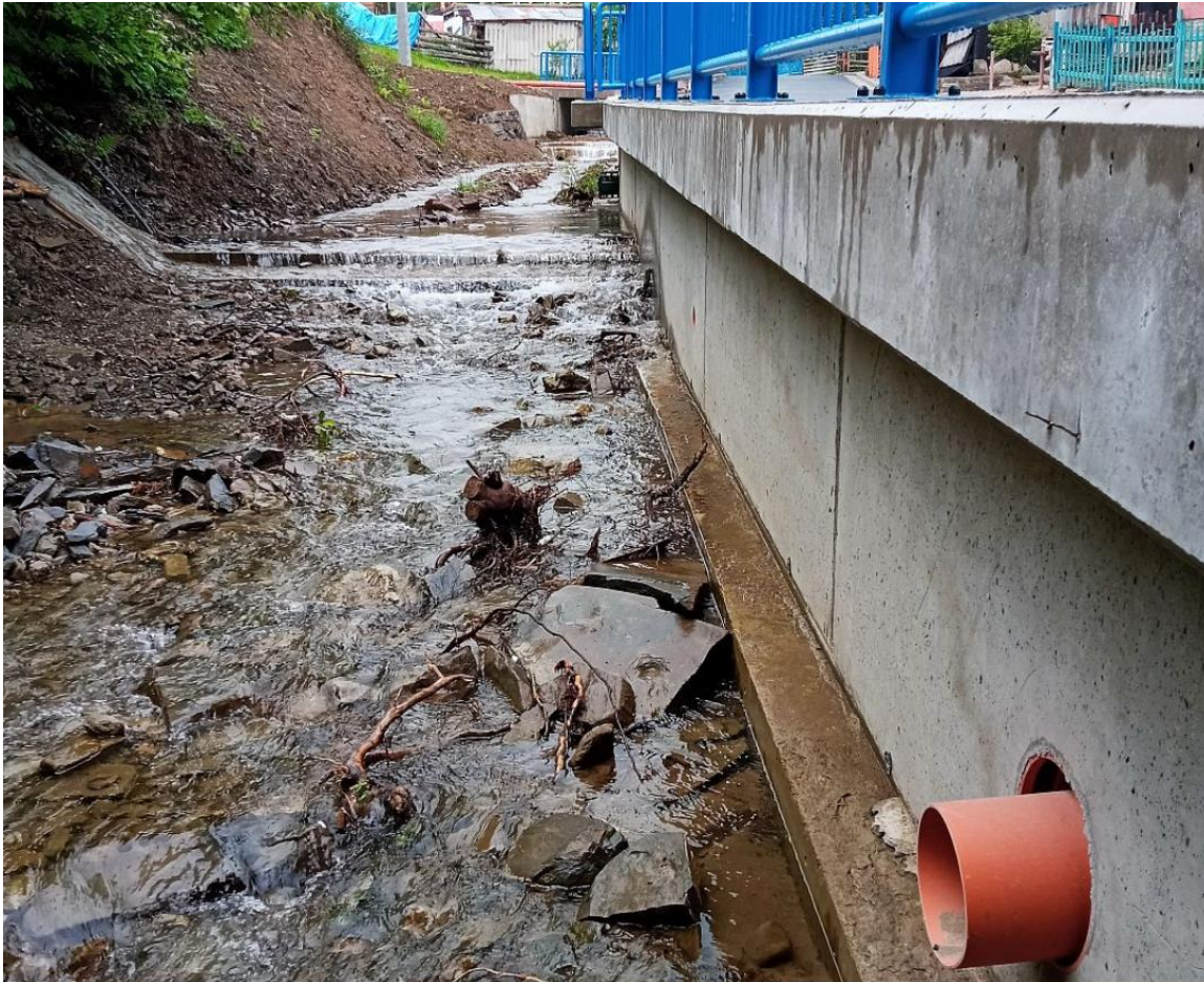
Obr. 9. Nový oporný múr a úprava potoka v Malej Frankovej.
