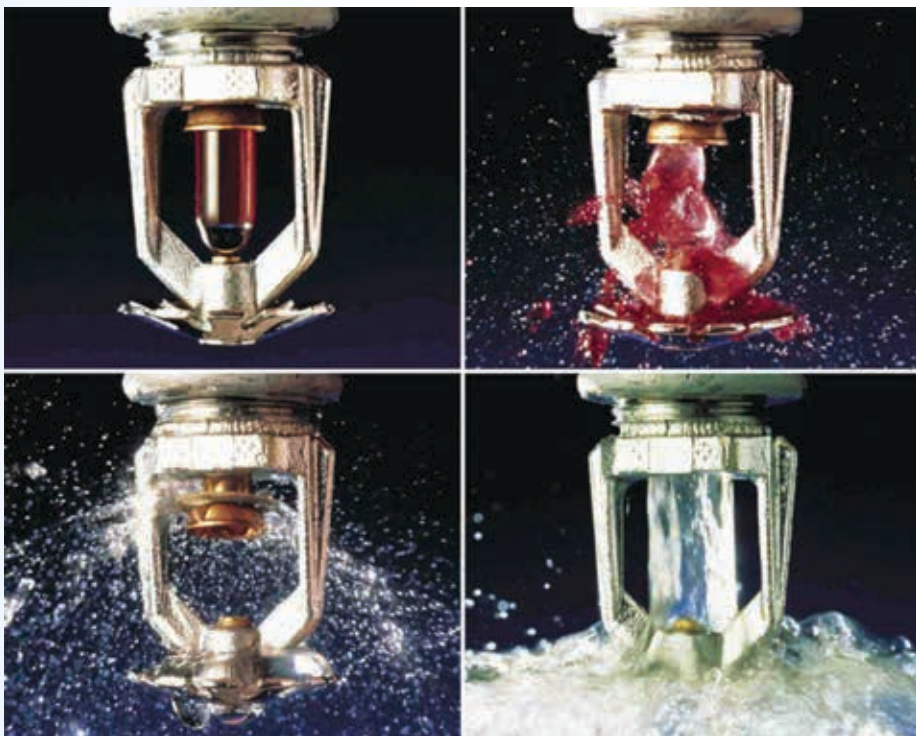
Otvorenie sprinkleru pri dosiahnutí otváracej teploty
