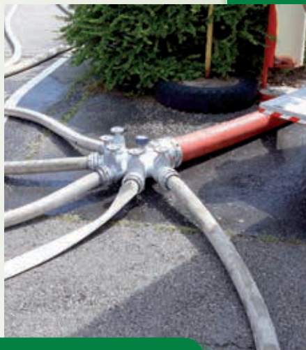
Príprava prejazdového mostíka cez komunikáciu v obci Nový Tekov a päťzdelovač pre ďalšie hadicové vedenia pri vstupe do SE EMO
