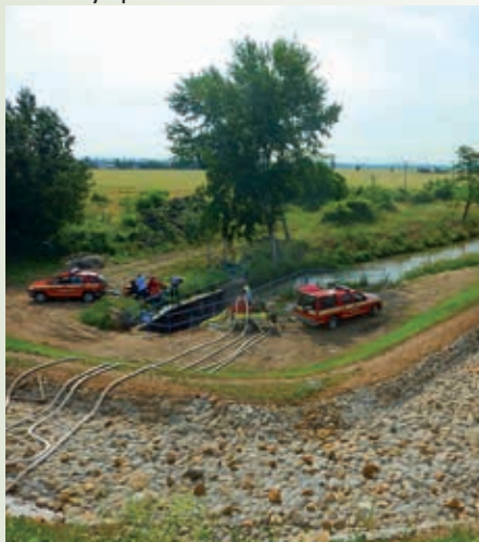
Prečerpávacie stanovište pre kyvadlovú dopravu
